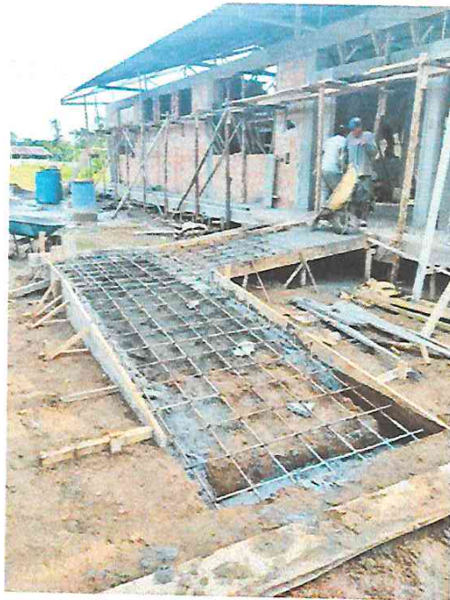
Fotografía N° 04.- Vista de los trabajos de la estructura en la rampa. CONSORCIO PIRUMBA WALTER ZEGARRA AREVALO REPRESENTANTE COMÚN
